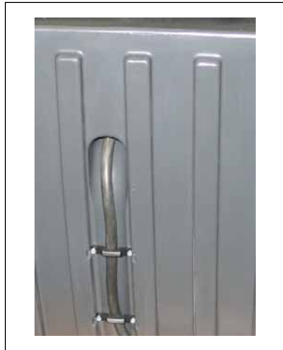
Fig. 6: Dragavlastning: Dragavlastningsklämmor på avskiljarens utsida
